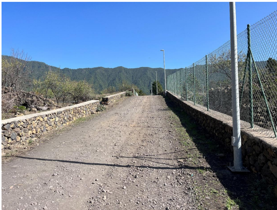
Imagen 8. Estado actual de la vía.
