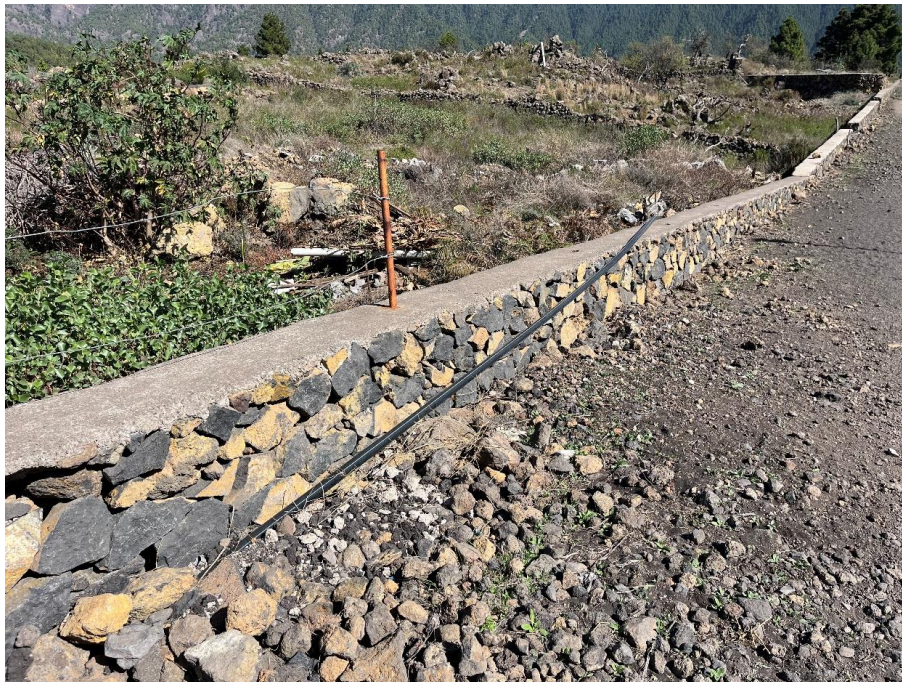
Imagen 3. Instalaciones existentes a tener en cuenta.
