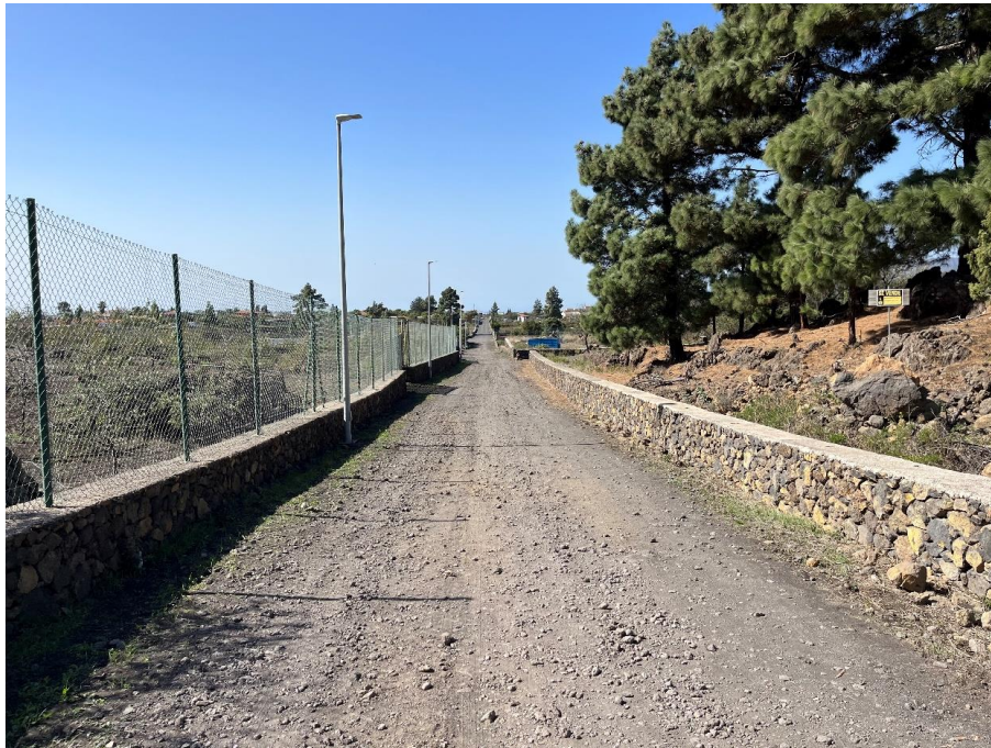
Imagen 7. Estado actual de la vía.
