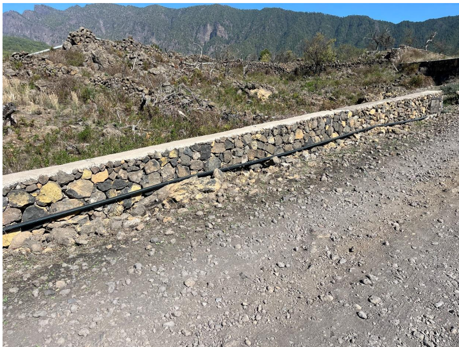
Imagen 4. Instalaciones existentes a tener en cuenta.
