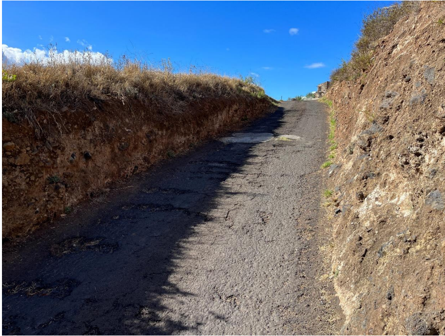
Imagen 7. Zonas a desbrozar y limpiar.
