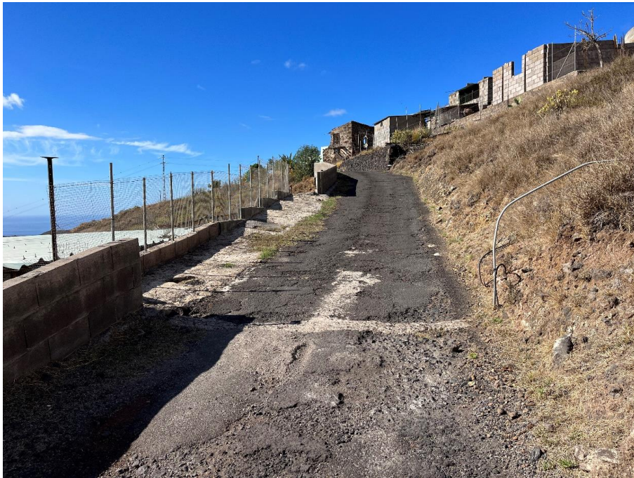
Imagen 8. Instalaciones existentes a tener en cuenta.
