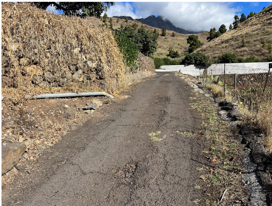
Imagen 4. Zona actual de la vía.
