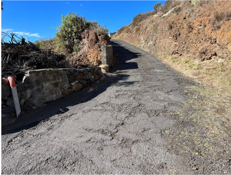
Imagen 5. Zona actual de la vía.
