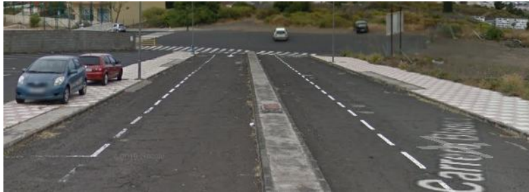
Ilustración 1. Estado Actual. C/Las Laderitas
