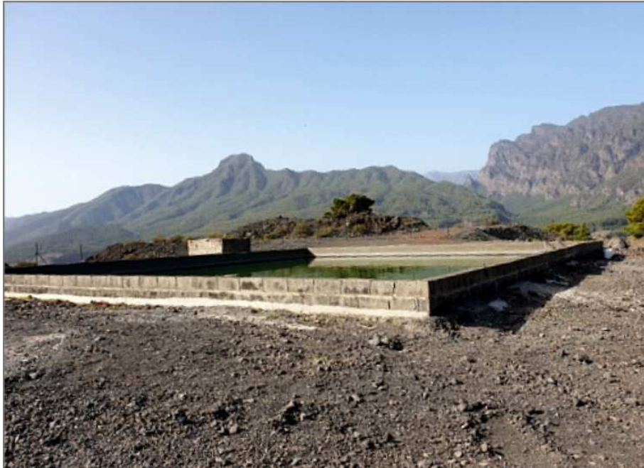
FOTOGRAFIA 11 Depósito municipal para abastecimiento de medios aéreos
